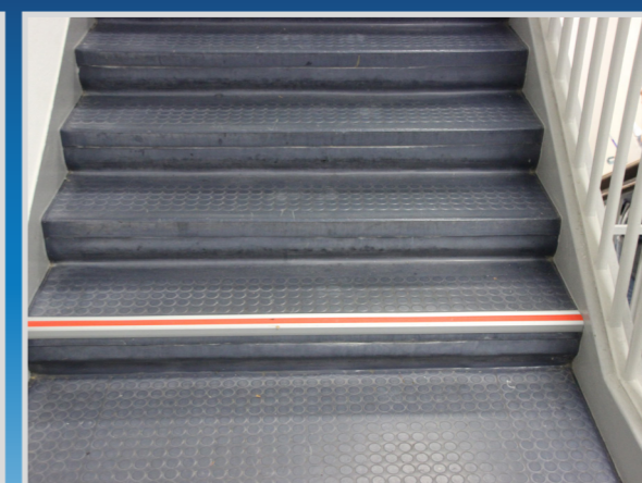
Nachleuchtende Markierung von Treppenstufen
