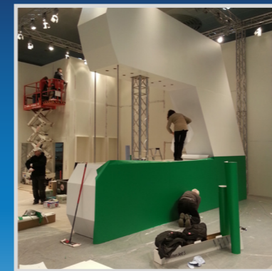
Verklebung von Digitaldrucken auf einen Hohlkörper
