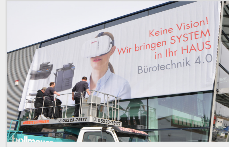
Montage einer Spanntuchanlage, licht- und sichtdurchlässig an einer Fensterfront.
